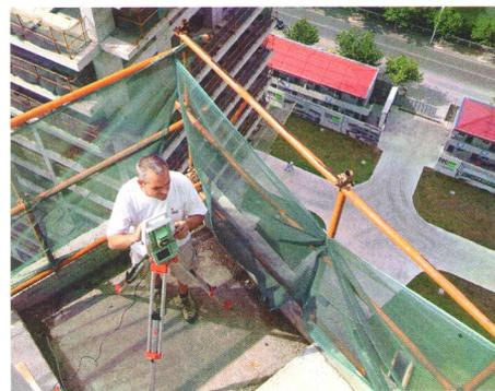
Die beiden Techniker der HMQ AG dokumentierten in Form von CAD-Daten alle Punkte, mit denen nun Krapf die komplette Gebäudehülle plant. Und sie erstellten ein millimetergenaues Fixpunktnetz über die ganze Baustelle. Dieses Netz ermöglicht die aktuellen Gebäudeaufnahmen, aber auch spätere Aufnahmen und Absteckungen mit höchster Präzision. So können bei Montagebeginn die Bezugsachsen und Bezugspunkte für die Montageequipe der Krapf AG mittels Metallplaketten markiert werden.
