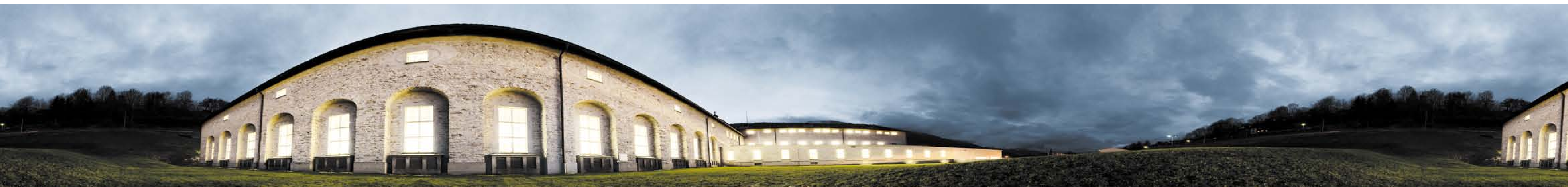
Centrale idroelettrica Küblis | Wasserkraftwerk Küblis
