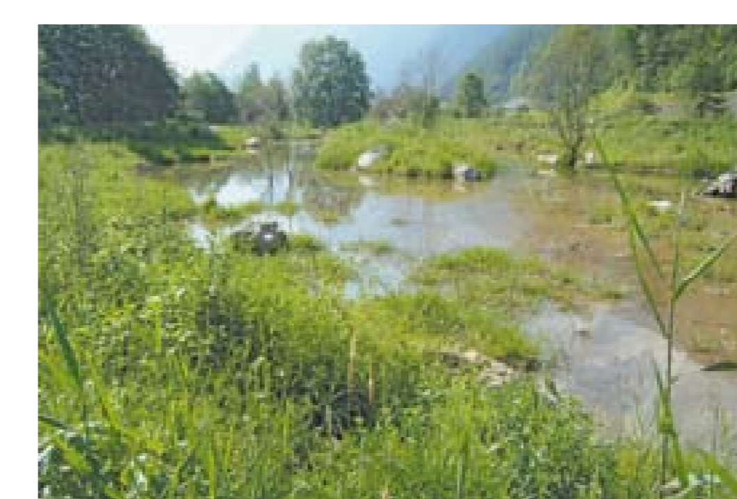
Un tratto dell'Acquasela dopo l'intervento di ripristino | Flussabschnitt bei Acquasela nach Renaturierung
