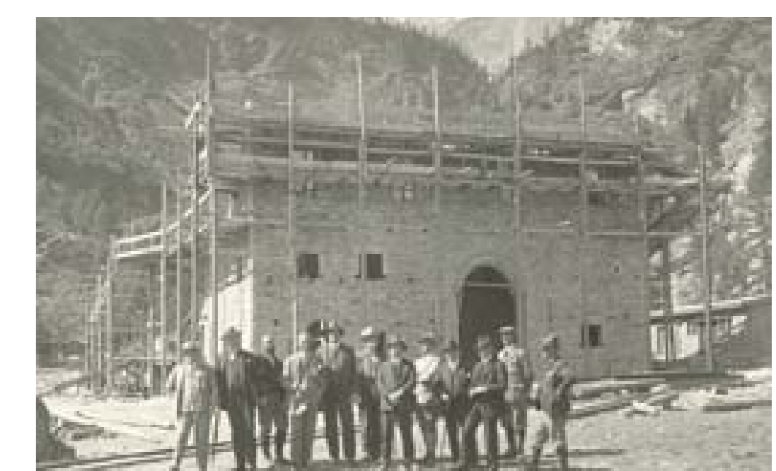
Costruzione della centrale di Cavaglia | Bau des Kraftwerks Cavaglia
