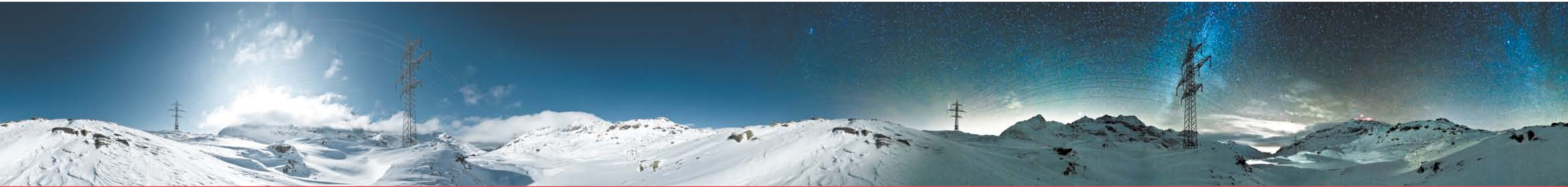
Elettrodotta del Bernina a 380 kV | 380-kV-Übertragungsleitung am Berninapass
