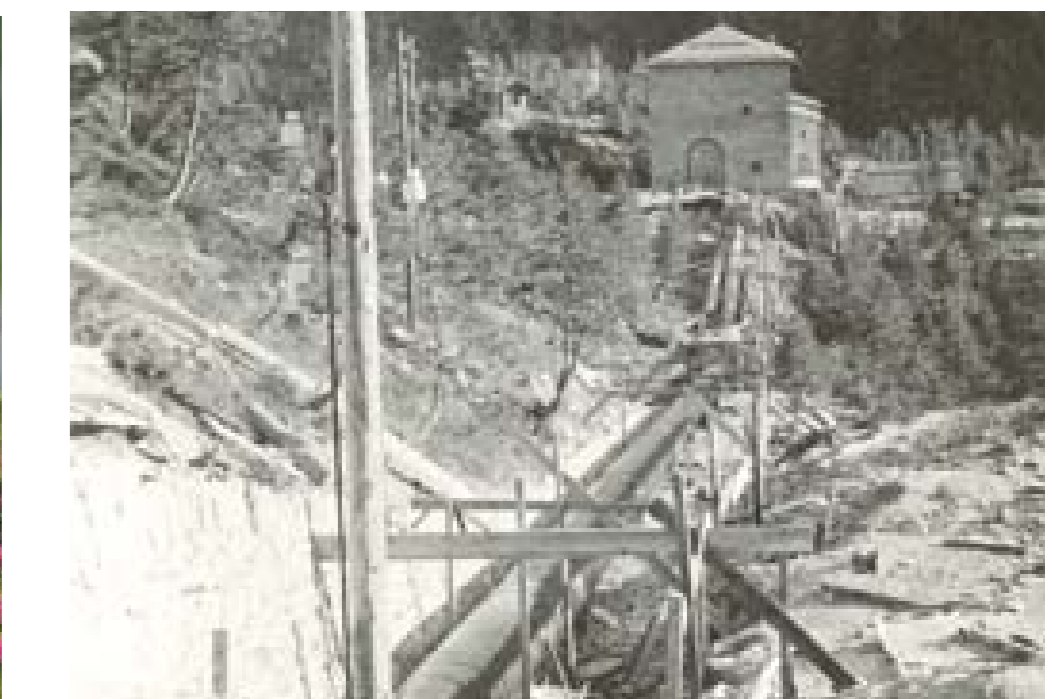
La condotta forzata che scende verso la centrale di Palù Druckleitung zum Kraftwerk Palù
