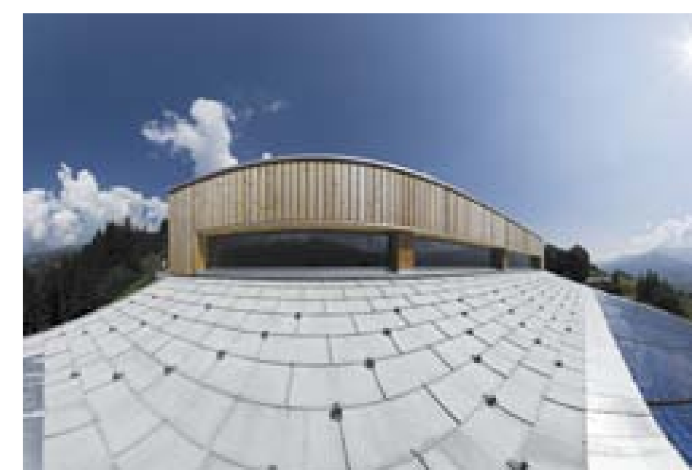
Impianto fotovoltaico certificato «naturemade star» a Siat (Surseiva) | «naturemade star»-zertifizierte Photovoltaikanlage in Siat (Surseiva)
