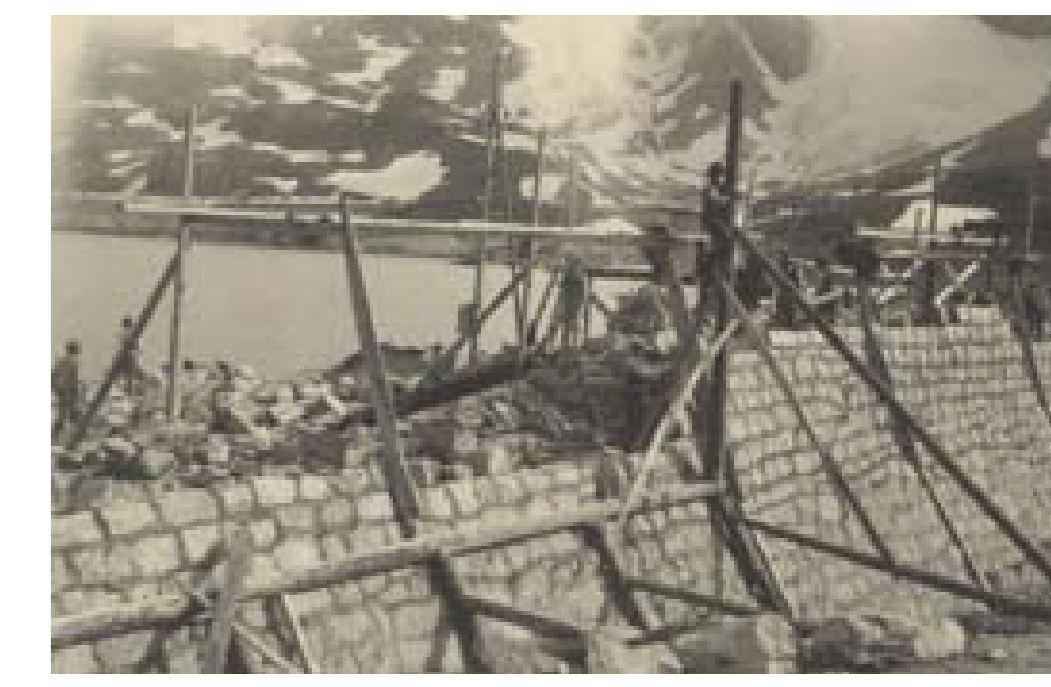
Costruzione della diga al Lago Bianco Staudamm-Bau am Lago Bianco
